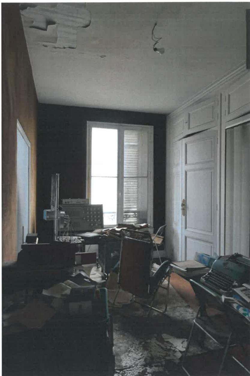
Une fenêtre au fond de la pièce à double vantaux, simple vitrage. L'armature bois est en mauvais état, nombreuses traces de coulure. Les volets à l'extérieur sont en très mauvais état.
