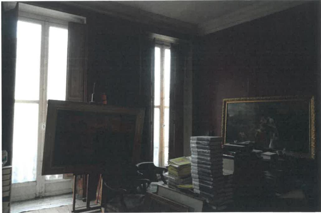
Fenêtre de gauche, armature bois, simple vitrage, quatre carreaux. Petite balustrade en pierre. La fenêtre donne côté rue.
