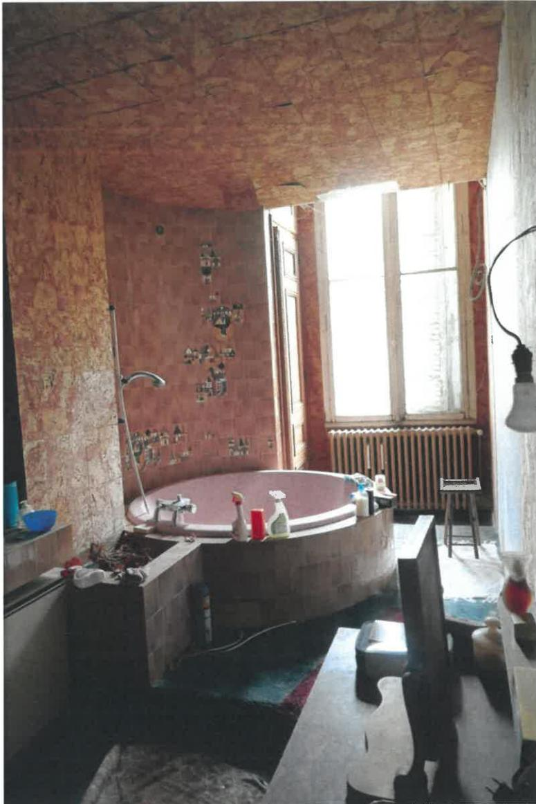
Présence d'un chauffage sous la fenêtre à double vantaux. L'armature bois est en mauvais état, noircie, des zones accidentées, de la matière qui est manquante. Les volets extérieurs en bois sont en mauvais état. La peinture est rongée, le bois également. Cette fenêtre donne sur le jardin.
