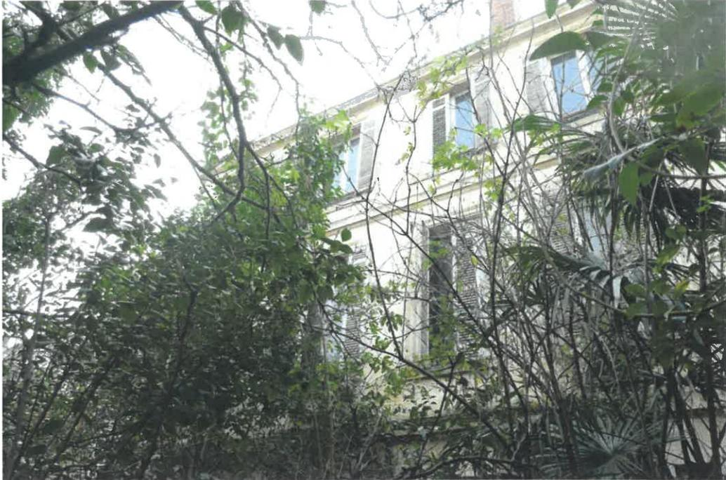
Les volets des fenêtres des deux étages se situe à l'extérieur, contrairement à la façade avant. Les volets sont en bois, en mauvais état.
