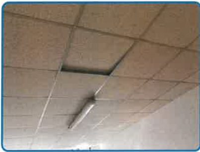
PRLV n° 1 sur Faux plafond Plaques polystyrènes
