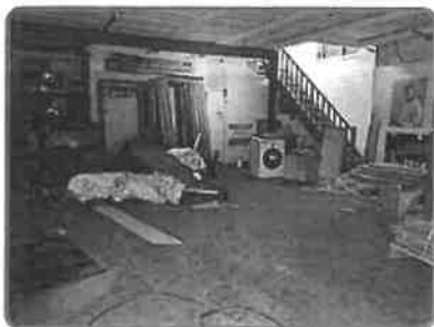
Local professionnel Rez de chaussée Hangar n°2
